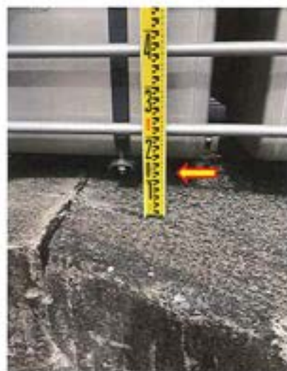
車両7 左側部～地面高さ : 12cm
